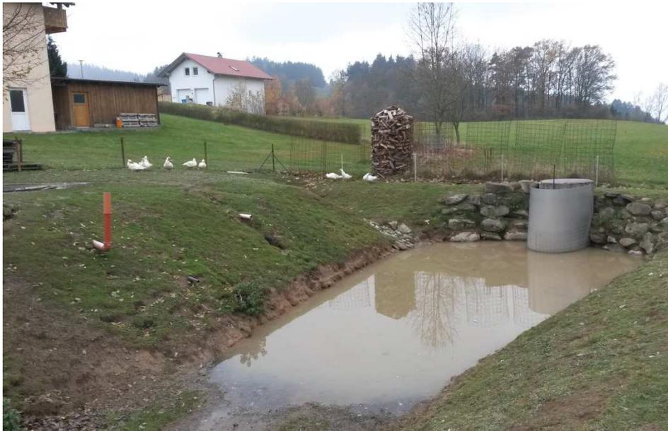
Abbildung 1: Regenrückhaltebecken 102RRB01 mit Drosselbauwerk
