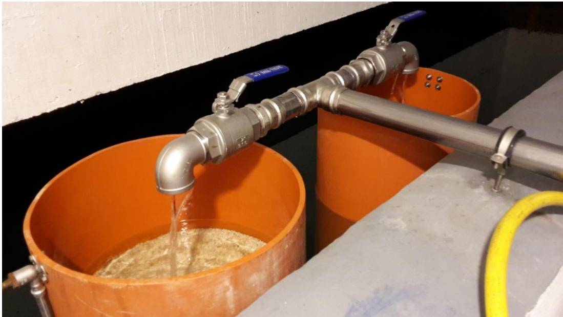
Abbildung 3: Zulauf Entsäuerungsanlage
